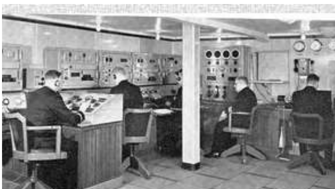
De radio receiving and control room van het RMS Queen Elizabeth GBSS
